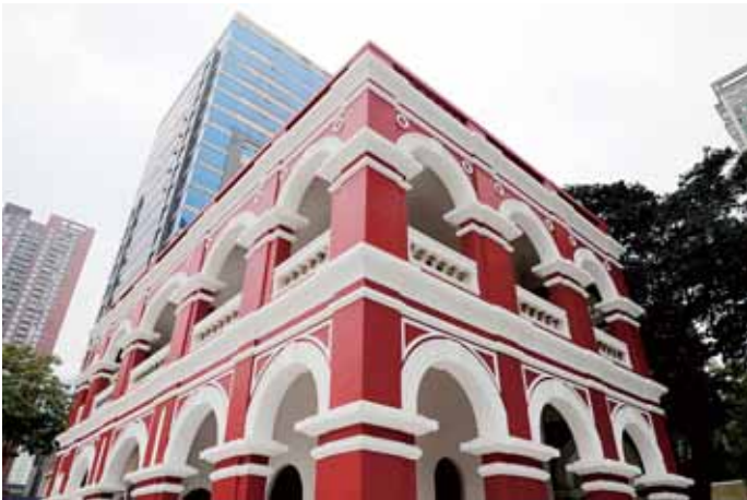
这是1月21日拍摄的位于广州越秀南路东园横路3号的省港罢工委员会旧址
