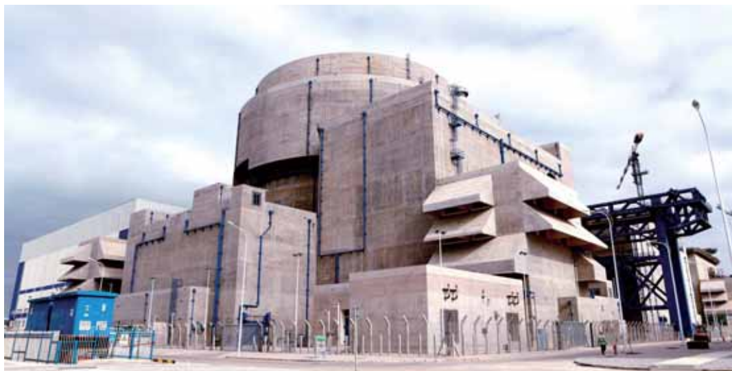
“华龙一号”全球首堆福清核电 5 号机组外景图。11 月 27 日 0 时 41 分,我国自主三代核电“华龙一号”全球首堆——中核集团福清核电 5 号机组首次并网成功。 ■新华社发
