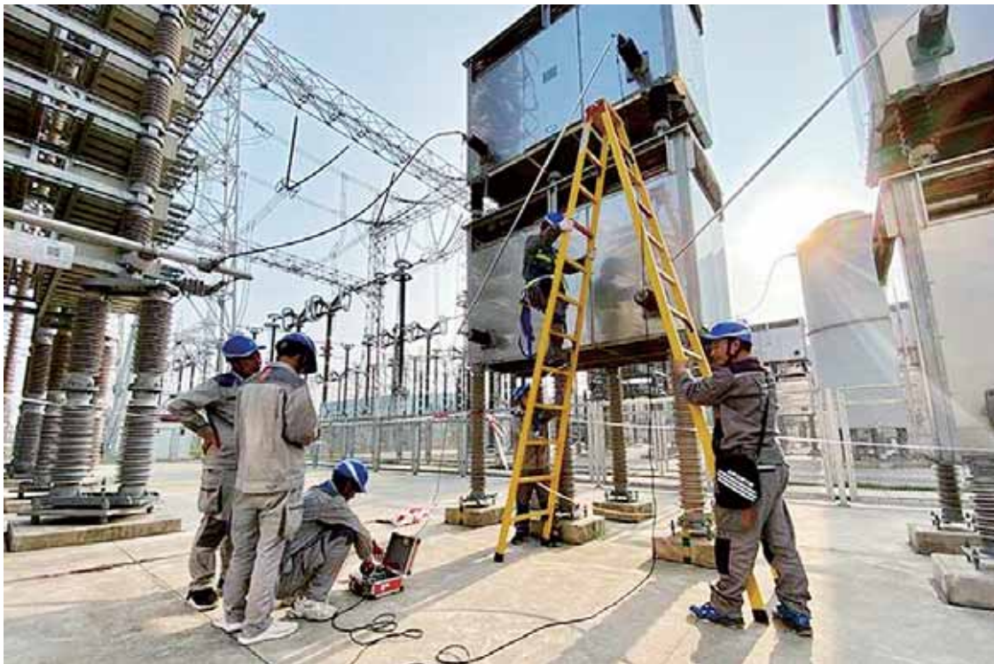
古泉换流站是一条将新疆风电、光伏等清洁能源与东部负荷中心连接的大通道,将新疆丰富电能源源不断送达安徽直抵华东。图为技术人员在进行检修。
