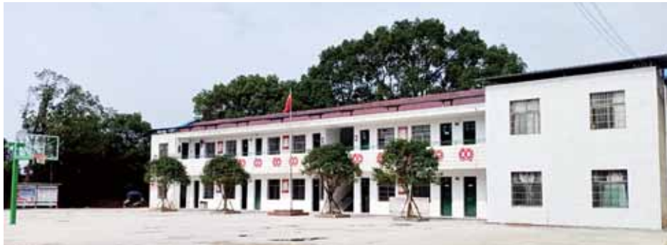
学校面貌焕然一新
