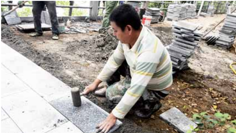
施工人员加紧铺设火烧板
