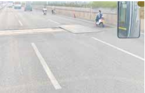
伸缩缝上已经覆盖了铁板
