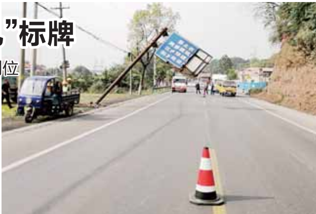
执法人员正在拆除非公路标志牌
