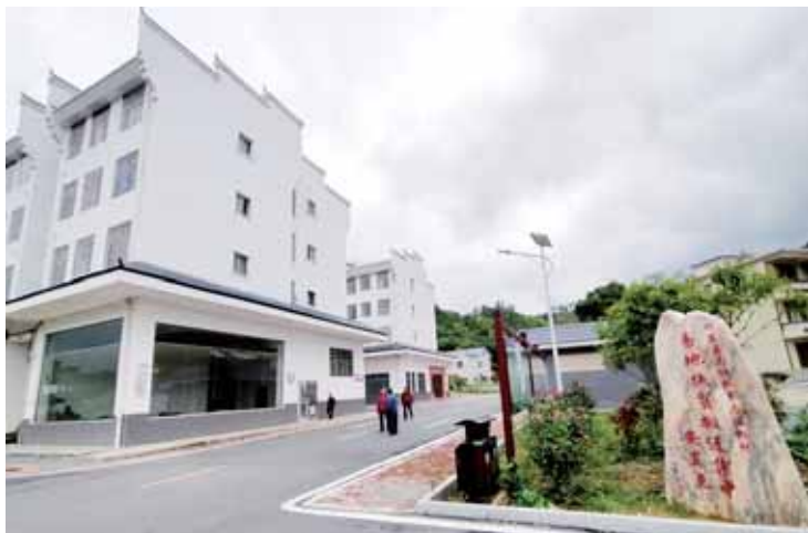
▲马杜桥村 易地扶贫搬迁集 中安置点
