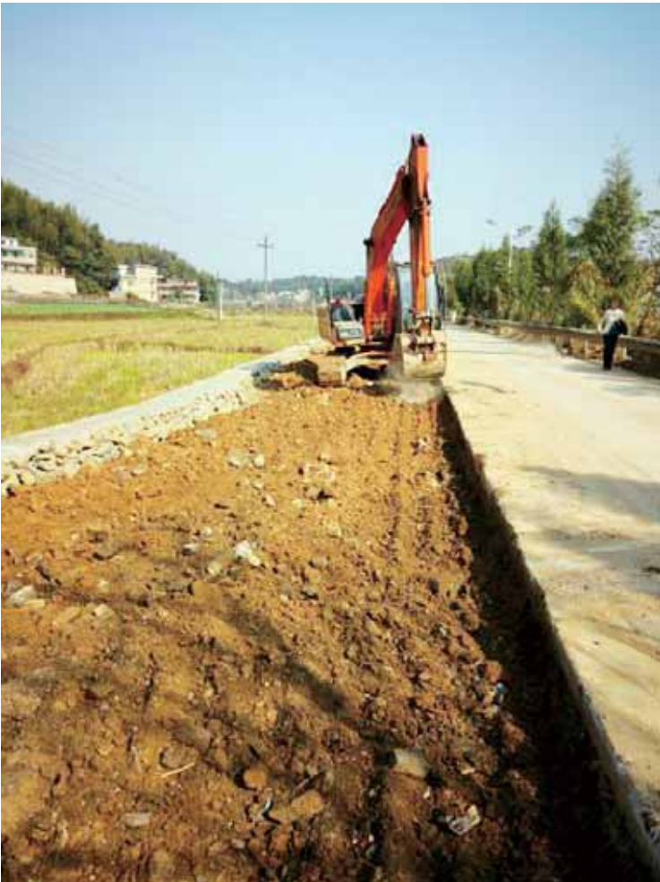
保新村道路拓宽施工现场
