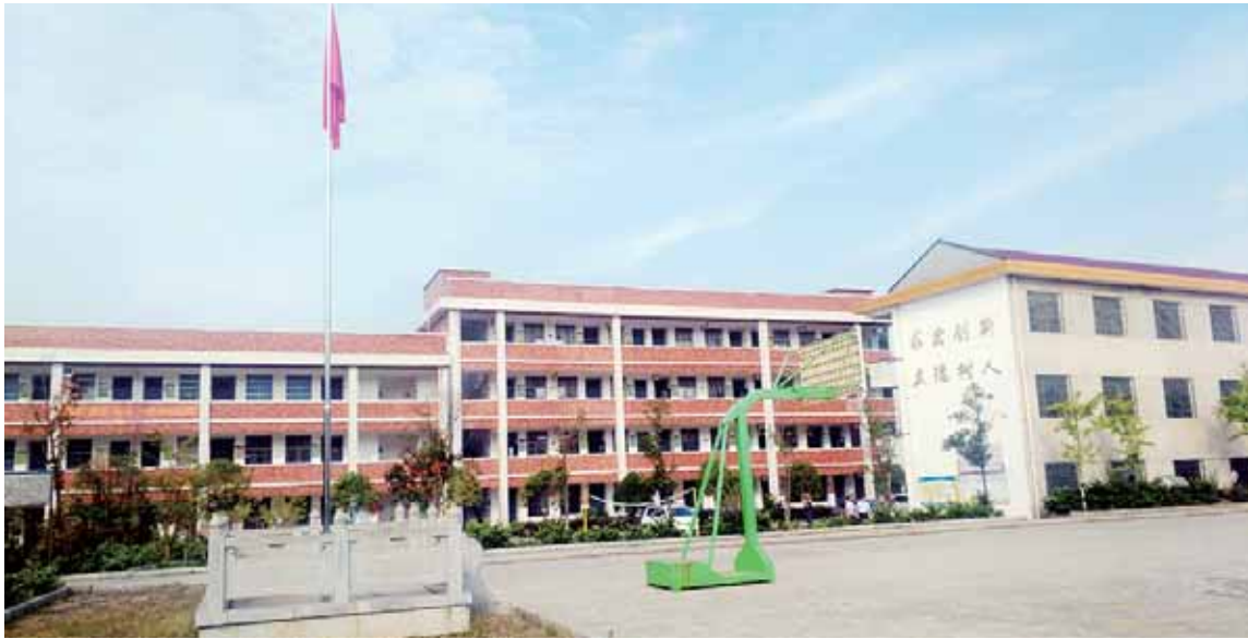
金兰镇贺市完小通过“薄改”工程面貌焕然一新
