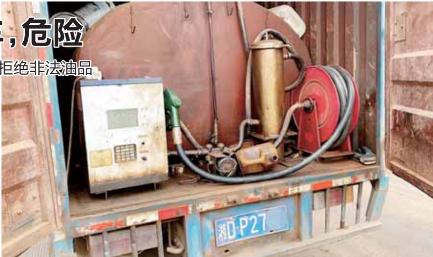
该移动加油车没有相关安全设施的保障,极易发生火灾或者爆炸事故
