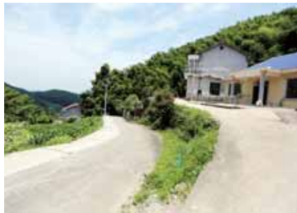
扩宽的道路和改造好的贫困户房屋构成一幅乡村美景
