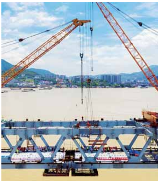
连通仓山区和滨海新城,福州道庆洲过江通道跨江主桥合龙。
