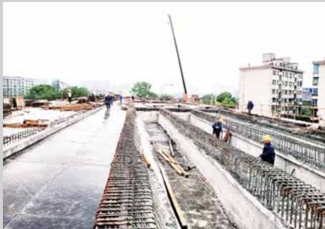
冒着细雨进行桥面施工
