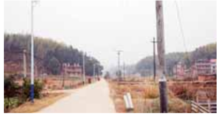
拓宽硬化的道路还装上了路灯
