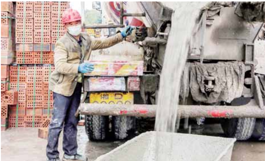
刘登国正在装运混凝土
