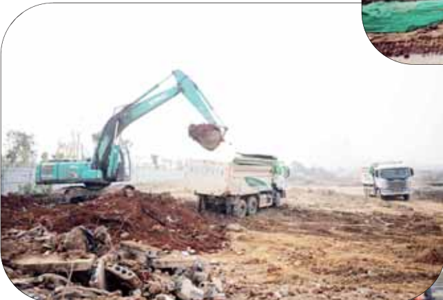
→珠晖区酃湖万达广场项目现场
