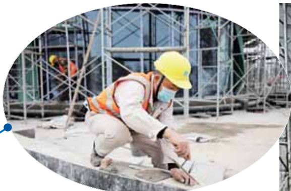
工人们正在紧张施工
