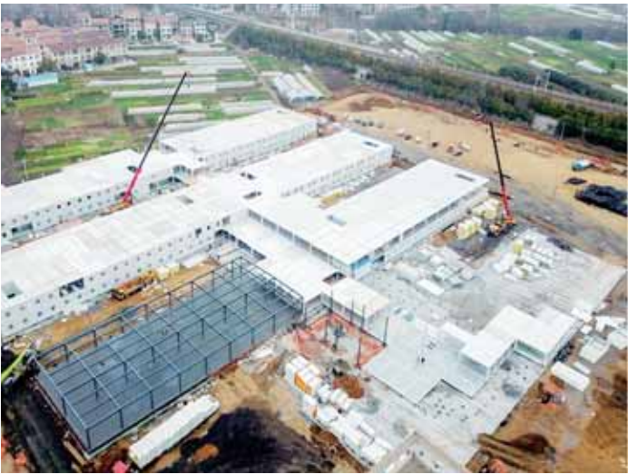
安陆版“小汤山医院”施工现场（资料图片）
