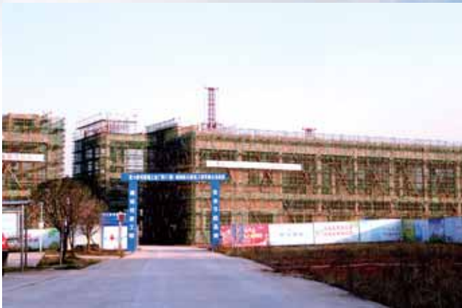
正在建设中的富士康厂区（二期）
