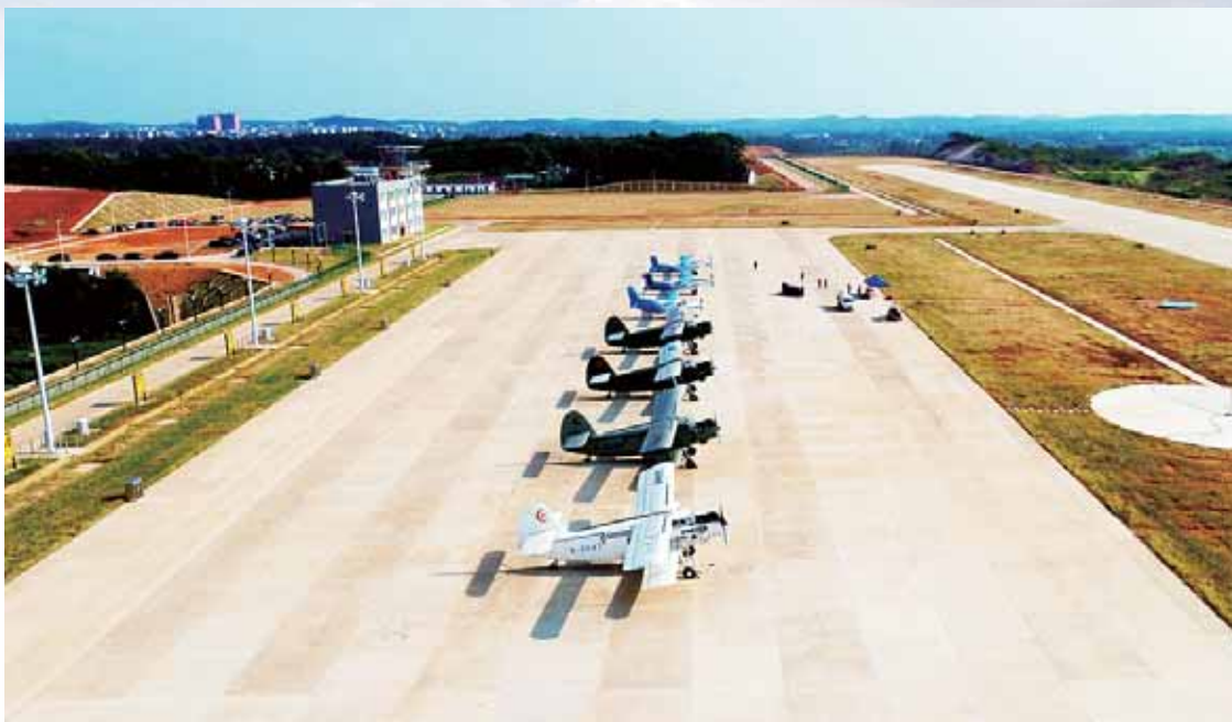
大浦通用机场一期主体工程完工，进入试运行。
