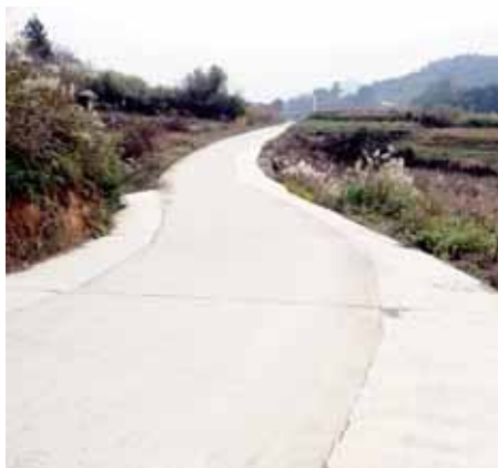
村里主要道路拓宽硬化
