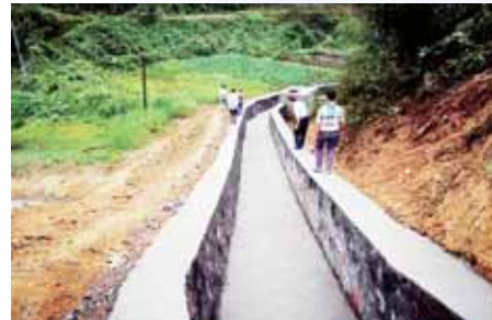
对安全饮水水库加固防渗
