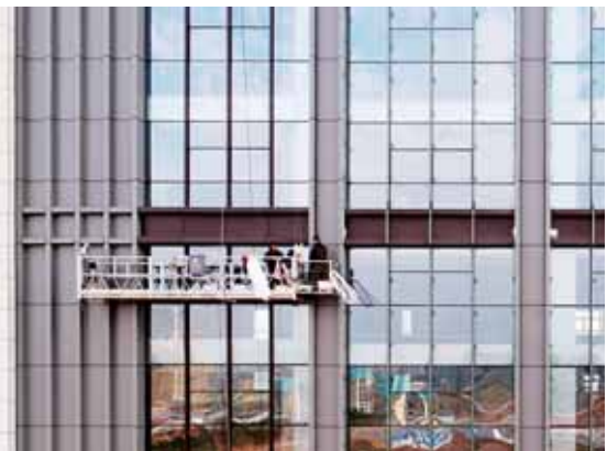
12月9日,记者在高新区陆家新区看到,工人正在对创新中心项目进行亮化和外装修工作。目前,该项目主体已封顶,外装修完成50%,内部精装修已完成65%,预计2020年6月建成投入使用。
