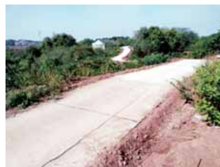
水泥马路通组到户
