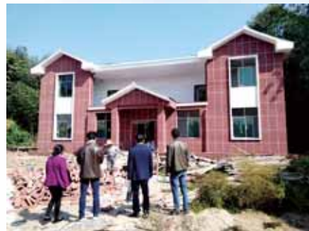
村民服务中心即将竣工
