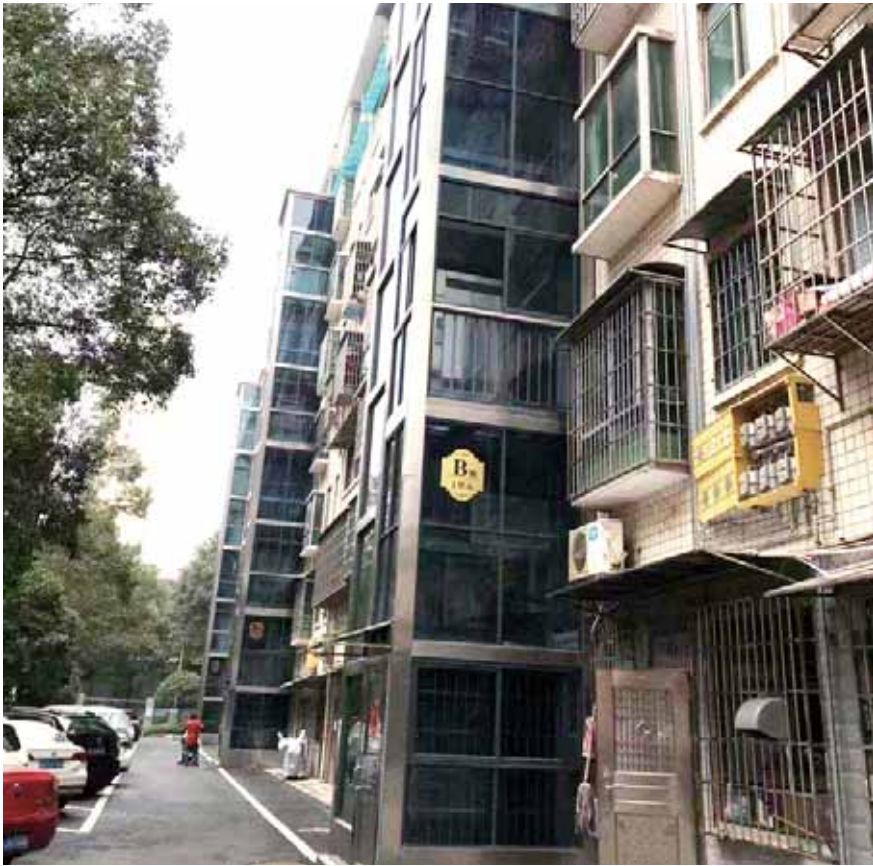
人大兴和花苑小区内加装的电梯➡
