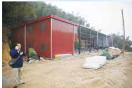
石山茶厂扶贫车间正在加紧建设中
