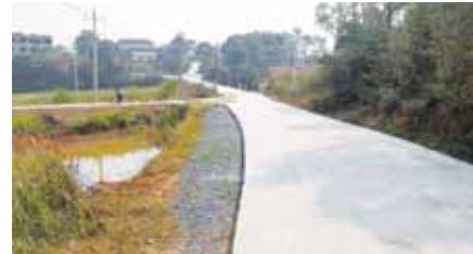
今年刚硬化完工的通组公路。
