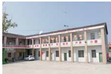
经过提质改造后,村部大楼和村小学面目一新。
