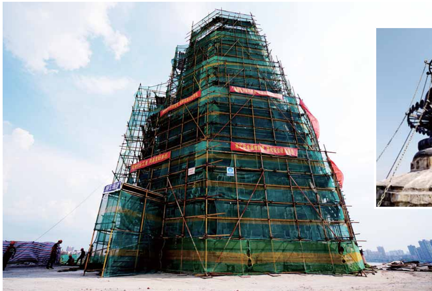
▲ 修复后的塔刹 李宇 摄 ◀ 正在修缮中的来雁塔 王翟 摄
