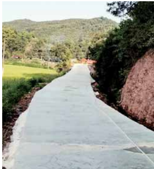
村内新修的水泥马路
