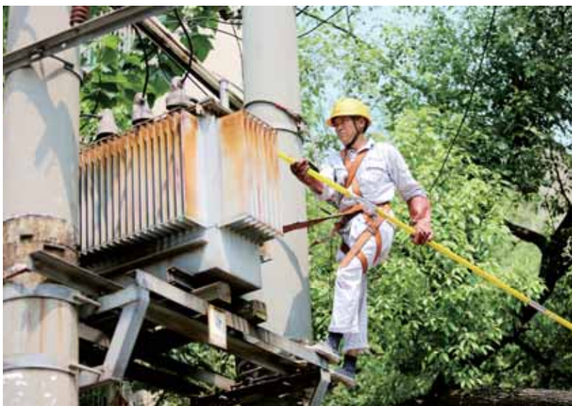
作业前断电检查
