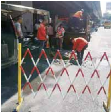
施工人员对破损的污水井盖进行更换
