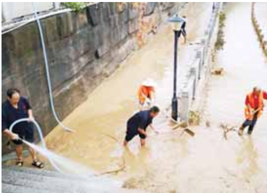
清除淤泥,冲洗亲水平台。
