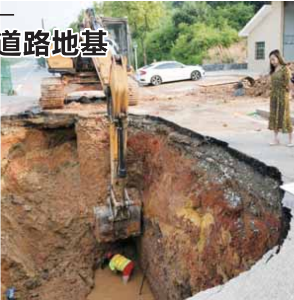
施工人员掘挖坍塌坑洞,探明流水来源。
