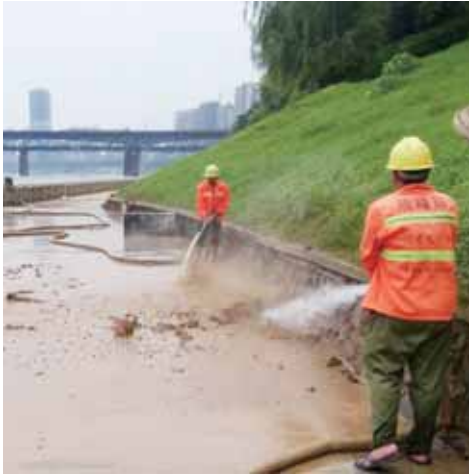
两支高压水枪同时发力冲洗亲水平台淤泥
