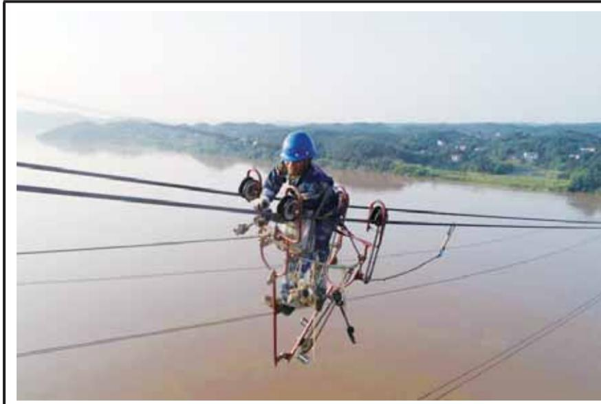
近日,国网衡阳供电公司220千伏栗君线开展停电抢修。220千伏栗君线#137-#138塔跨越洙水河,档间距670米,杆塔呼高77.7米。由于档距跨越大,需要用飞车将检修人员传送到指定位置,解开粘连的分裂子导线,补加并更换间隔棒;经过6个小时的奋战,终于圆满完成任务。据悉,这是该公司近年来首次对输电线路在跨江杆段开展检修。
