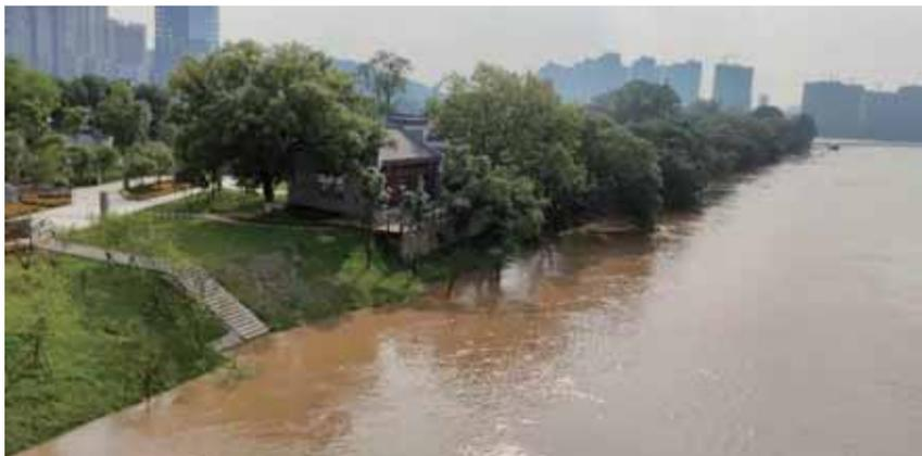
现洪峰水位 49.21 米, 距警戒水位差 1.29 米, 洪峰流量 1240m<sup>3</sup>/s; 14日8时, 双牌水库下泄流量 3280m<sup>3</sup>/s, 欧阳
