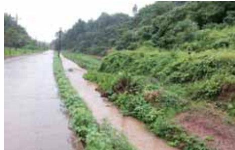
旧水渠一遇涨水就淤塞漫堤
