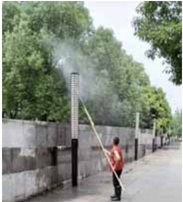
采用高压喷枪清洗广场照明灯饰
