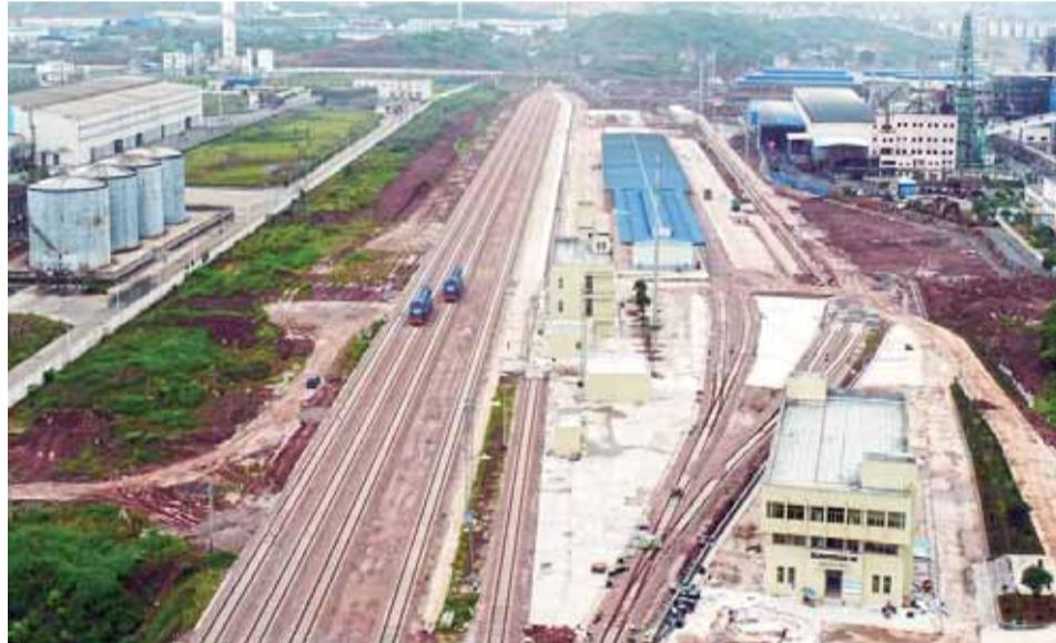
5月20日，记者从常宁市水口山镇瓦松铁路项目了解到，铁路已全线拉通，5月5日成功完成机车过轨测试，目前广铁集团正对接轨站及区间进行全面验收。瓦松铁路专用线项目是水口山金铜项目配套工程，南端接轨京广线瓦园站，向西下穿京广高铁接入常宁市水口山镇，并在现有水口山八厂南侧与金铜项目厂址之间新建企业站，通车后可有效缓解中国五矿铜铅锌产业基地、水口山地区及沿线企业的货运问题，大大降低企业运输成本。
