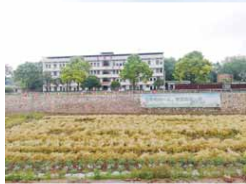
过去破败的村部如今面貌一新,以前一片坍塌荒芜的护坡新砌得整整齐齐。
