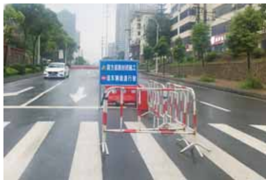
万达路口竖起封闭施工提示牌
