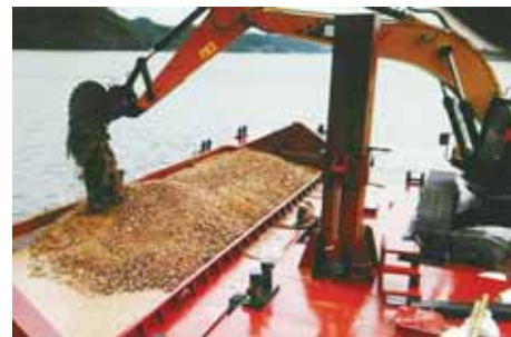
动用大型设备浚深拓宽航道 胡亚华 摄
