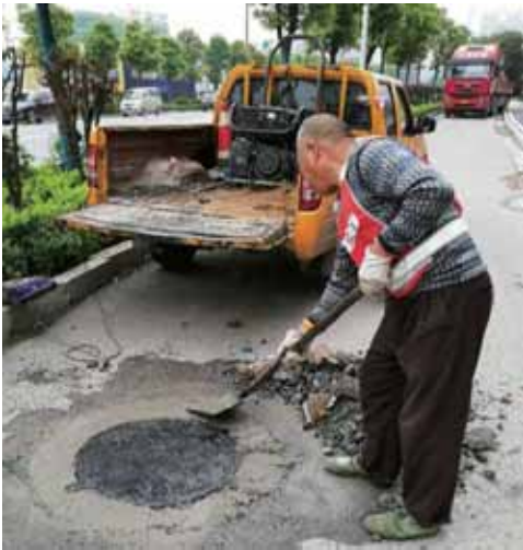
对沉陷的检查井盖进行重新安装改造
