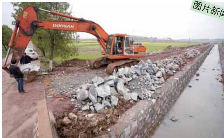
3月25日，石鼓区角山镇和平村，施工人员正在抢抓晴好天气修建银杯干渠。据了解，去年底，石鼓区启动对银杯干渠主干渠的高标准改造，目前，整条干渠主体工程只剩下和平村境内不到300米的一段。施工方介绍，4月1日前，整条干渠将全部拉通。
