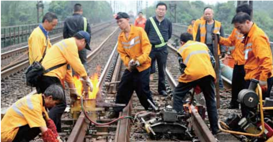
焦柳线第一阶段集中修拉开帷幕, 广铁工务大修段全体员工加强复杂地段的施工调查和安全预想, 层层压实安全责任, 确保施工安全。图为近日该段在施工现场检查焊轨作业质量。 陈志清 摄
