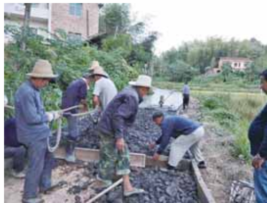
石江村公路硬化
