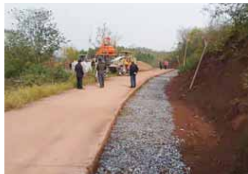
扩建村组公路施工现场
