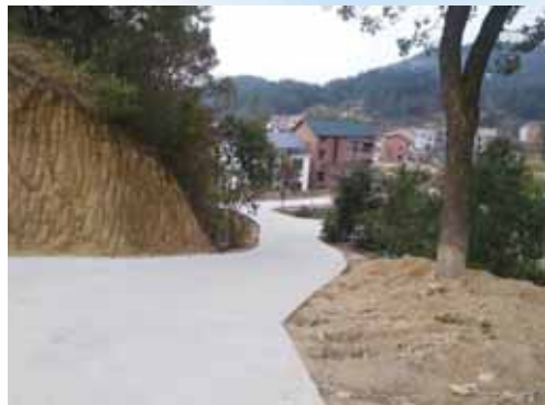
通组公路硬化后
