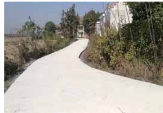
硬化后的村道
