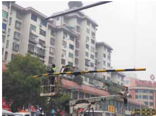
施工人员在高空作业车上维修断裂的钢索 胡亚华 摄
