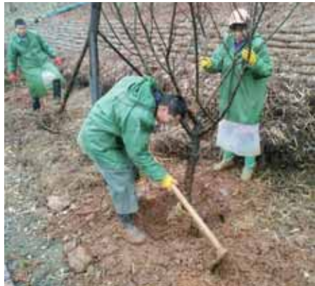
施工人员顶雨冒寒加紧栽种桃树 胡亚华 摄
