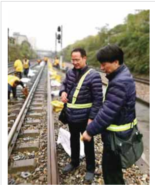
广铁工务大修段换轨二车间党总支严格落实集团公司、段党委的工作部署，全体党员在党总支的带领下，发挥开路先锋精神，人人勇挑重担，确保了年度目标实现。图为近日段领导在该车间现场调研。 ■陈志清 吴绍武 摄
